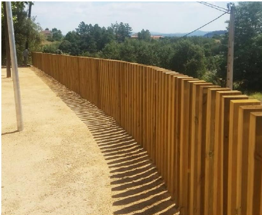
Figuur 8: Voorbeeld van een afsluiting tegen everzwijn bestaande uit houten palen met 5 cm tussenruimte (Rosell et al., 2016)
