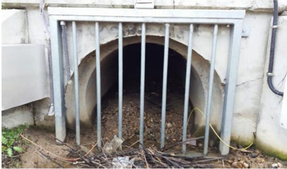
Figuur 9: Hekwerk dat het gebruik van een irrigatie(water)afvoerbuis door everzwijnen onmogelijk moet maken (Rosell et al., 2016)
