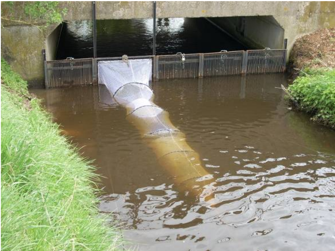
Figuur 5: Bovenaanvicht op de permanente vangstconstructie met opgespannen fuik.
