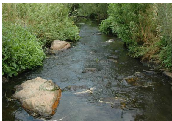
Figuur 4: Vegetatie langs beide oevers van de visdoorgang zorgt in de zomerperiode voor schaduw en beschutting terwijl de grote stenen in de visdoorgang de stroomsnelheid diversifiëren.
