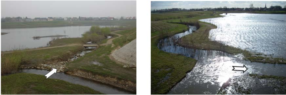
Figuur 26: Enkel bij een hoge waterstand van de Maas is de verbinding (pijl) tussen de visdoorgang en de Dilkensplas watervoerend.
