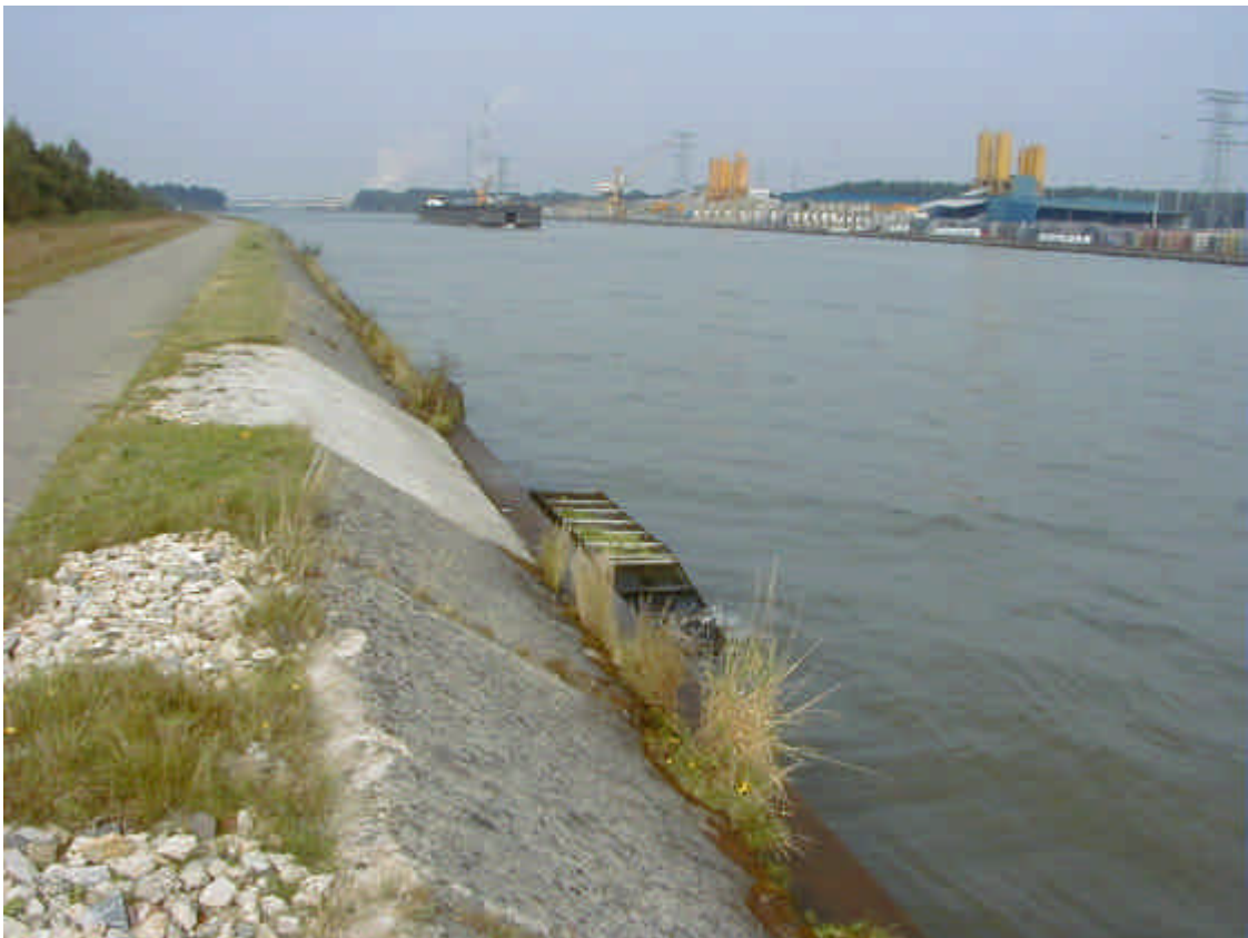
Fig. 5.27: Kanaal met harde oeverbescherming
