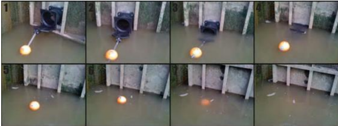
Figuur 5: werking van een kattenluik dat geïnstalleerd is op een grotere uitwateringsklep.
