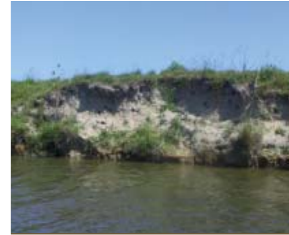
Steiloever met nestgaten van Oeverzwaluw in de niet afgegraven oever van de brede oeverzone met landinwaartse dijkverplaatsing te Mannekensvere.
