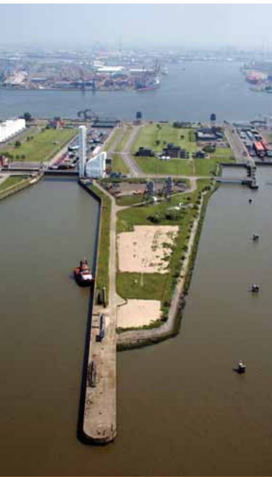
Inrichting van een broedterrein voor Visdief aan de Van Cauwelaertsluis – foto Gemeentelijk Havenbedrijf Antwerpen.
