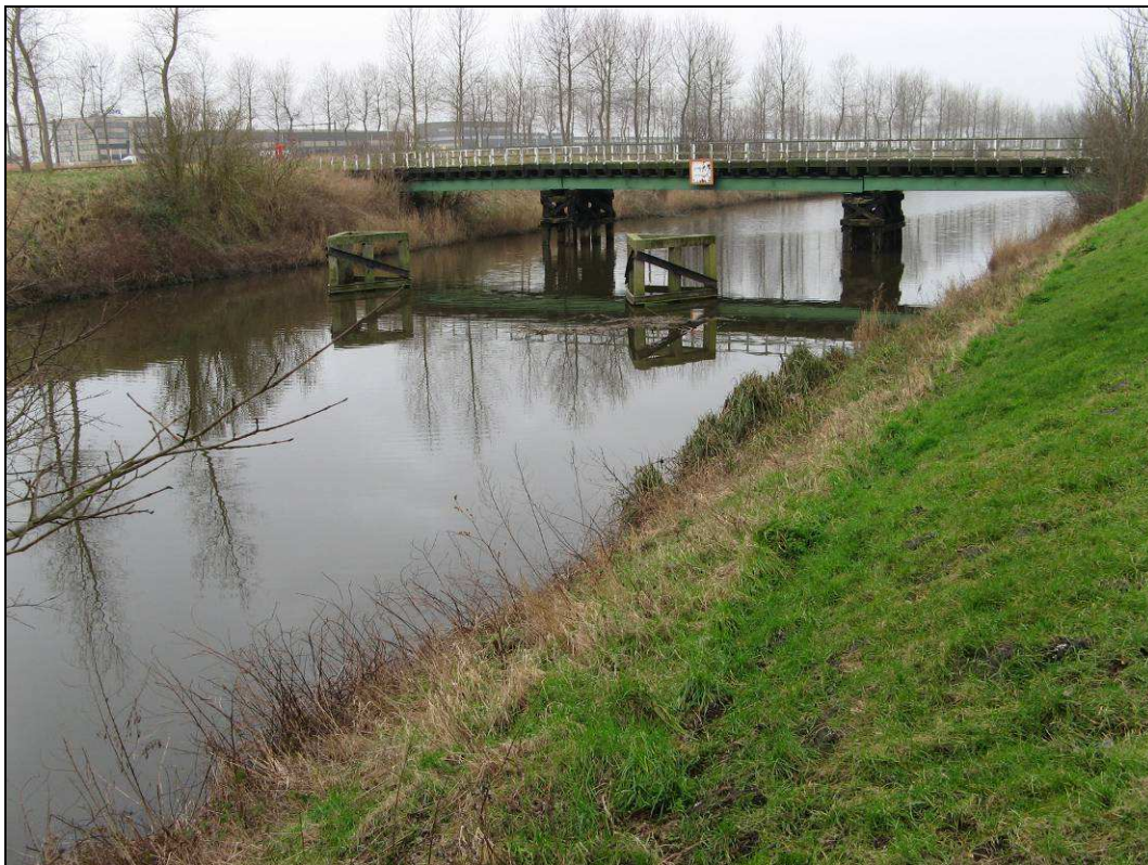
Foto 2. De voorgestelde alternatieve locatie voor het inrichten van een hengelpaats ligt net stroomopwaarts Ramskapellebrug. Hier komt een zwak ontwikkelde oevervegetatie voor en zijn er geen struwelen op het talud.
