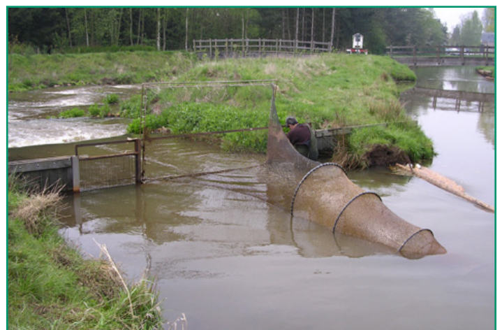
Figuur 3: Installatie van de vistrapfuij aan de bekkenvistrap in de Kleine Nete in Herentals. Rechts onder de brug ligt een onoverbrugbare stuw. Via de vistrap links kunnen vissen de stuw toch passeren.
