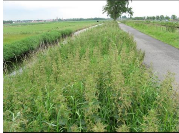
Foto 2: berm aan de zijde van het Langgeleed (9 juni 2010)
