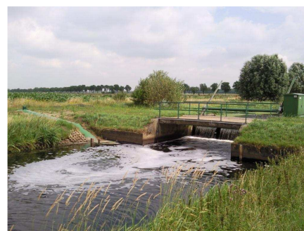
Ondergrondse geplaatste hevelvistrap bij de stuw Oijense Hut
