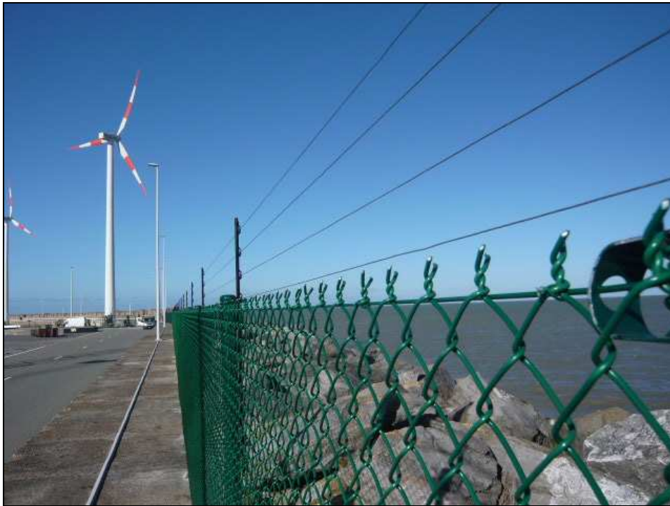
Foto 1. Afsluiting aan de Oostdam van Zeebrugge ter bescherming van het sternenschiereiland met schrikdraden met 12V stroom
