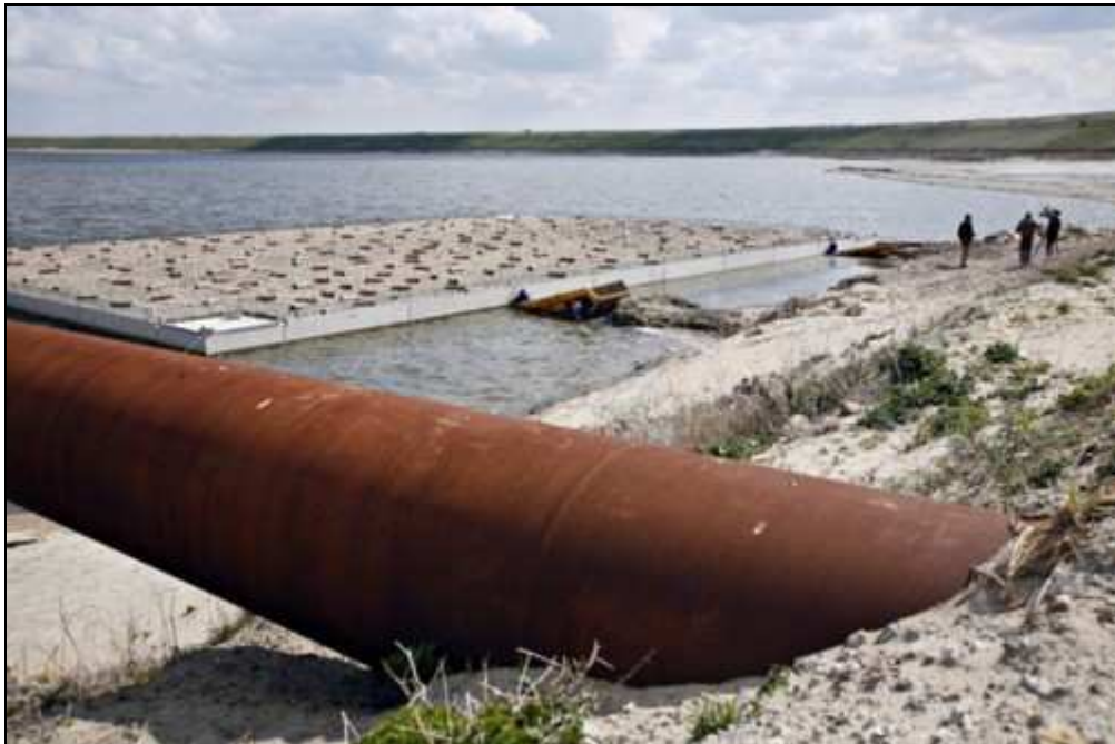
Foto 2. Aanleg van een kunstmatig vlot voor broedende stern in haven van Rotterdam. In een later stadium is het drijvend vlot verder uit de oevers geplaatst om er zeker van te zijn dat er geen predatoren naar de broedsite kunnen overzwemmen.
