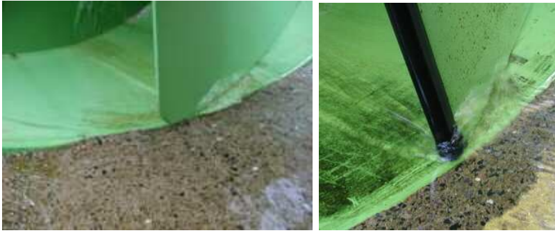
Figuur 2. links – uitstekende tip van de eerste winding. Rechts – aangepaste rand van de eerste winding met flexibele band.
