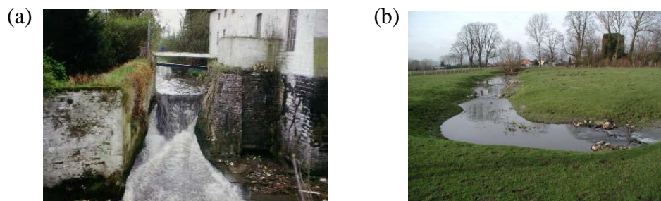
Figuur 1.7: Watermolen op de Kleine Gete (foto a). De vispassage die aangelegd werd rond de watermolen (foto b). In de omleiding werd gewerkt met streekeigen materiaal om het verval af te bouwen en de stroomsnelheid in te perken.
