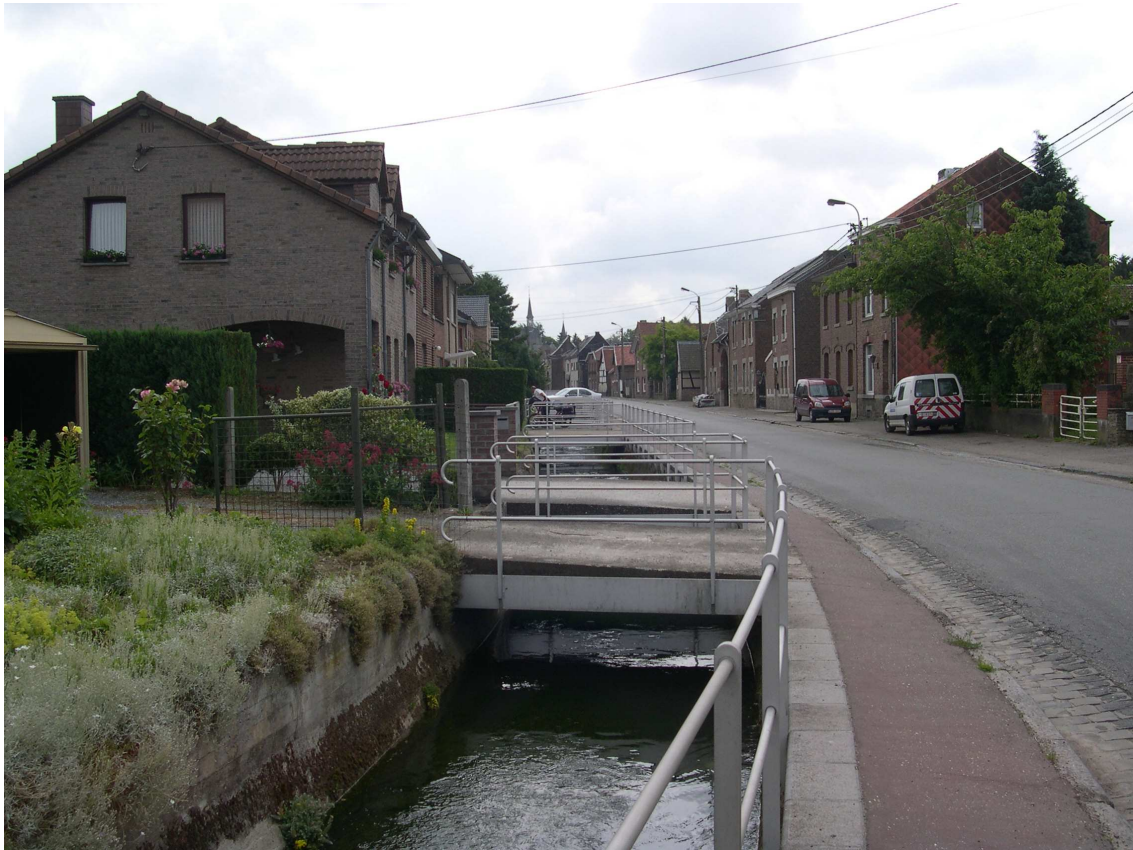
Balustrades met (te lage?) zijpanelen, ze vormen letterlijk tientallen knijpconstructies op de sectie van de Voer te 's Gravenvoeren
