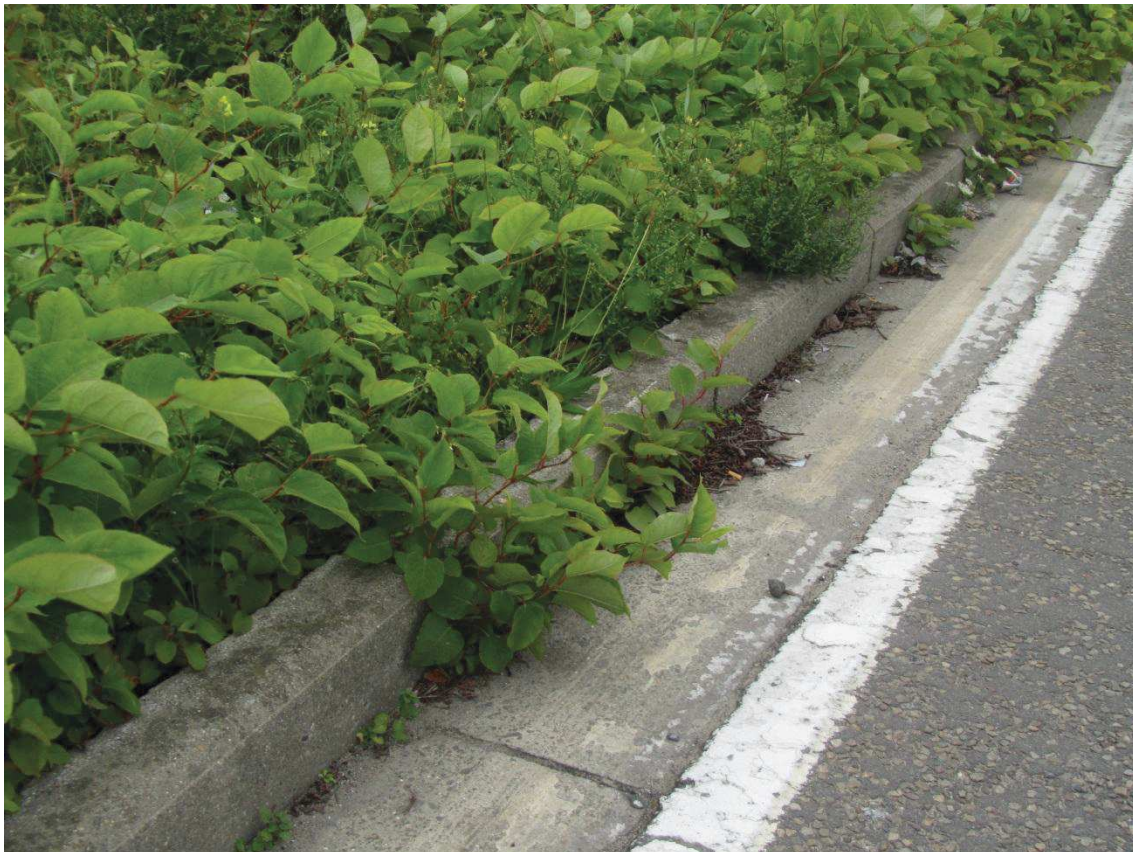
Foto 1 Een invasieve duizendknoopsoort groeit doorheen de wegrandafboording.
