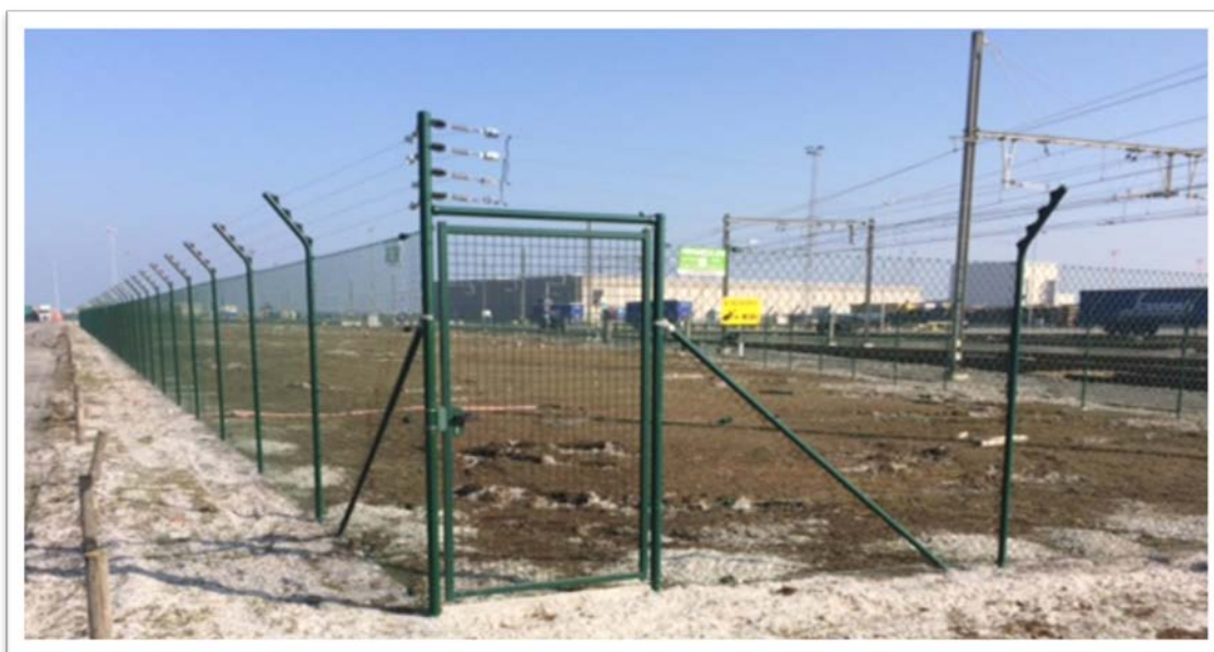
Figuur 5. In de voorhaven van Zeebrugge werd een 2 m hoge afrastering geplaatst voorzien van elektrische bovendraden en onderkruipbeveiliging om de vos en andere landpredatoren te weren.
