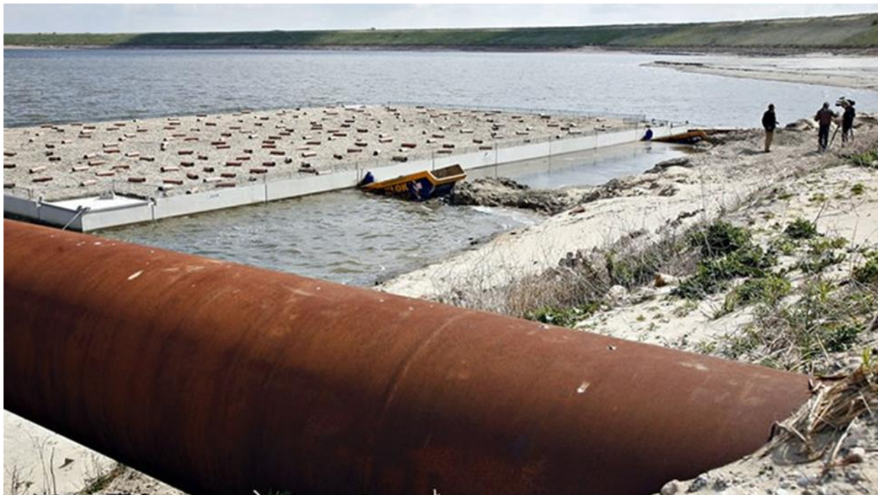
Figuur 2. Drijvend vogeleiland in de Slufter te Rotterdam. De ponton ligt hier nog tegen de kant, maar werd uiteindelijk verankerd op ongeveer 200 m van de oever. Het eiland is voorzien van een ondergrond van kiezels, schuilgelegenheid voor de kuikens en is afgerasterd zodat de kuikens niet in het water kunnen vallen.
