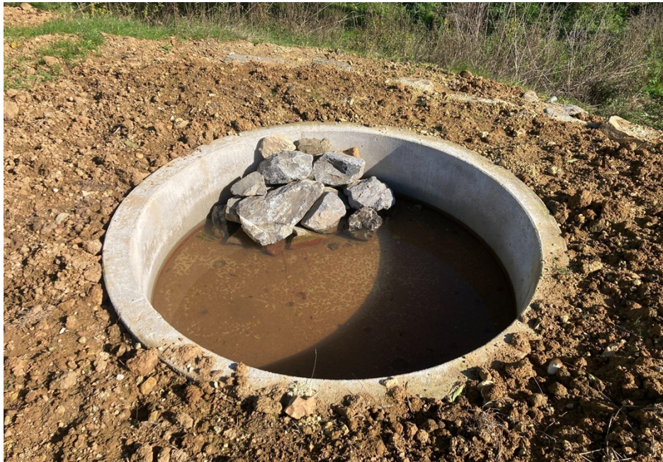
Figuur 4: betonnen bak bij aanleg in Altenbroek, Voeren. Deze bakken zijn geplaatst voor de aanwezigheid van de populatie vroedmeesterpad, maar kunnen dienst doen als voortplantingsplaatsen voor geelbuikvuurpadden indien gunstig beheerd.
