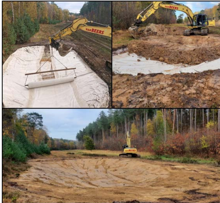
Figuur 6 – Aanleg van een poel in Dilsen met bentonietmatten.
