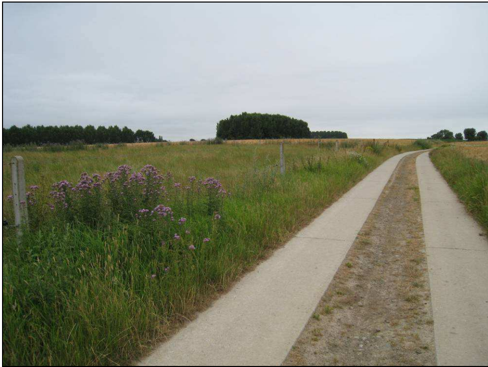
Foto 4. Een weg in tweesporenbeton met kruidenrijke berm.
