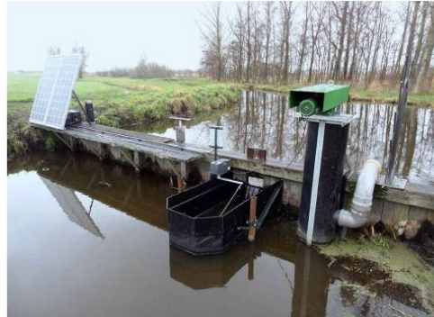
Figuur 4. Illustratie van een poldervissluis (Bron & foto: www.Arcadis.nl , http://www.beutech.nl/webroot/uploads/12082014124338-14-448-valueproposition_Vismigratie-pg07.pdf ).
