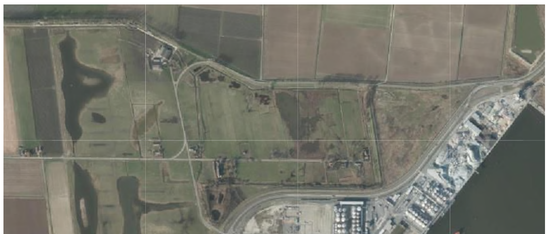
Figuur 18: Havenuitbreiding in 2021 (bron: Geopunt).
