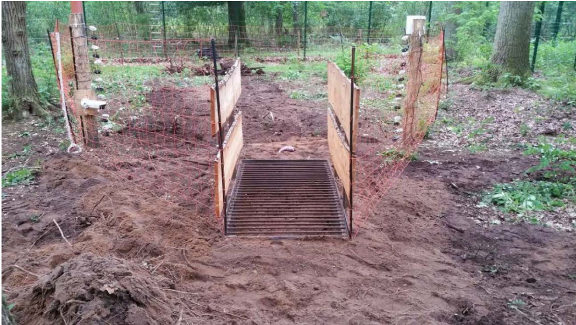
Foto 4: Wildrooster met smalle ronde staven gebruikt in Duitse studie naar de effectiviteit van wolfwerende maatregelen (Wolfcenter)
