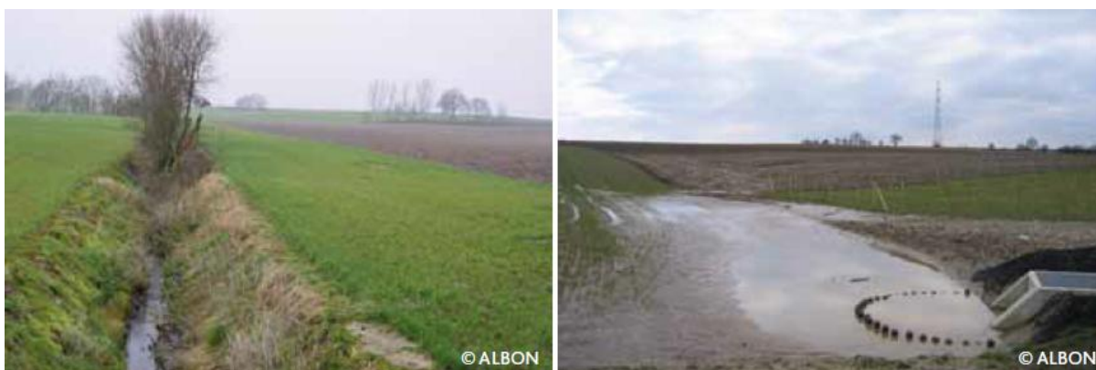
Foto 1 a en b: Grasbufferstrook en dam met erosiespoel. (Bron ALBON)
