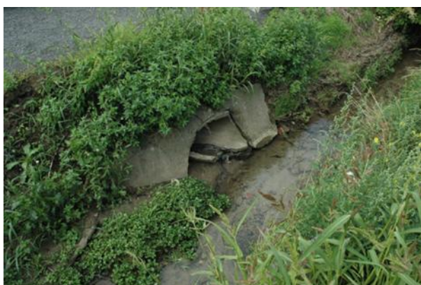
Figuur 18: Een lozingspunt bij afvispunt 2 in de Zevenbronnenbeek
