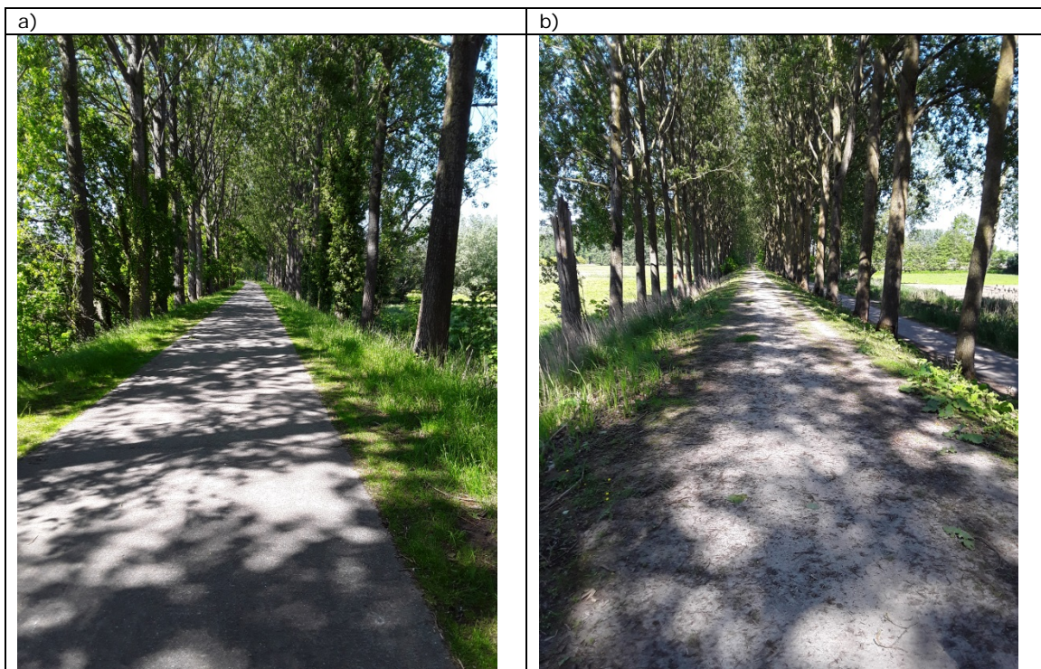
Figuur 3 : Koning Albertdijk met op de kruin de geasfalteerde weg (a) en Blanckaerdijk met onverhard pad (b) (foto's: Geert Flamand).
