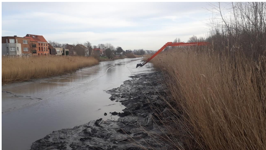
Figuur 2-9. Beeld van de uitgevoerde werkzaamheden met verreik-kraan ter hoogte van locatie 2 (foto Erwin Dieleman DVW – 4 maart 2020).
