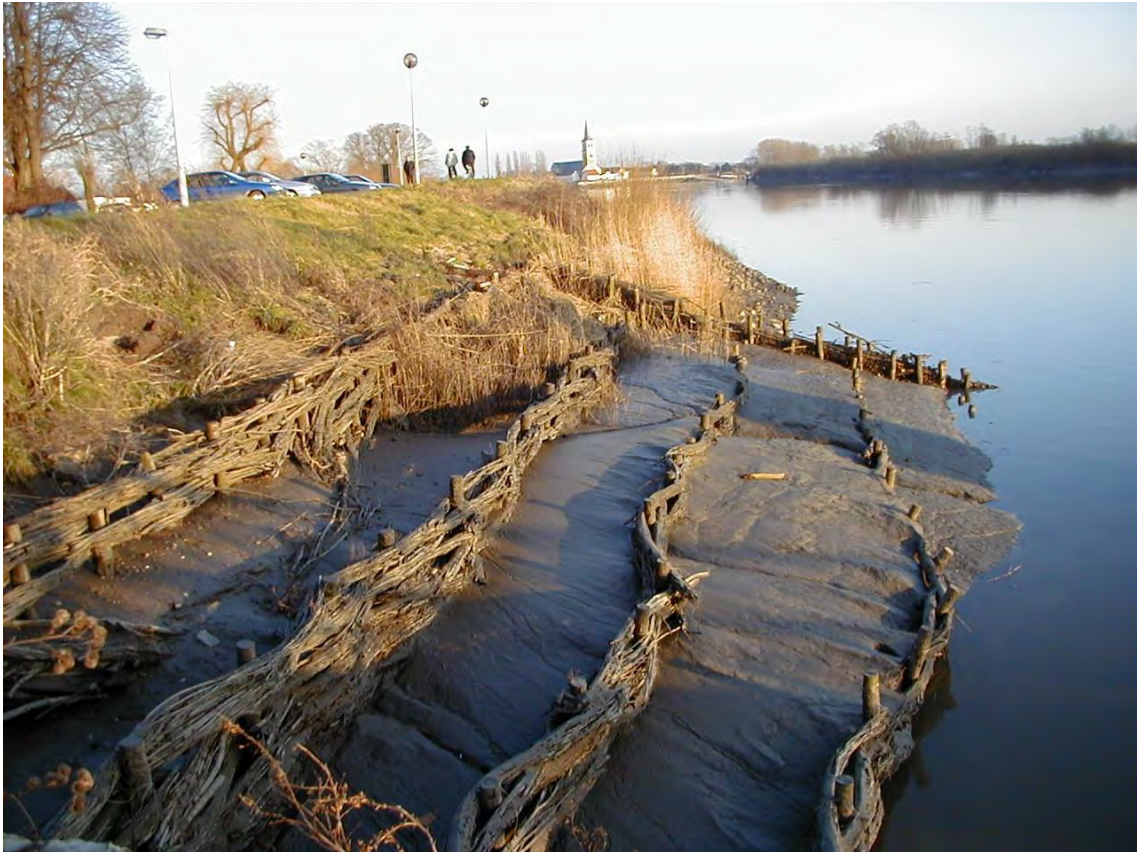
Figuur 1-8. Foto van schorrandverdediging met palenrijen en wilgenvlechtwerk Mariekerke (2001).
