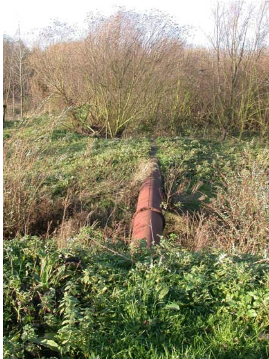
Foto 4.2. De afwateringsbuis tussen depot A6 en depot A3 (foto vanaf de berm van depot A6)
