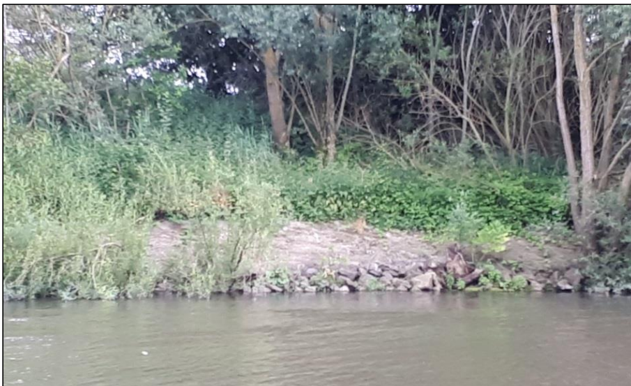
Foto 7. Oevers met asfaltmastiek.
