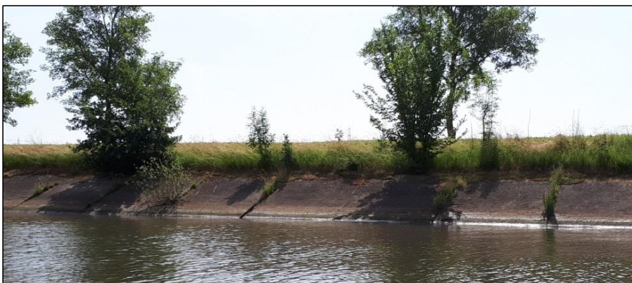
Foto 13. Oever met betonnen platen.
