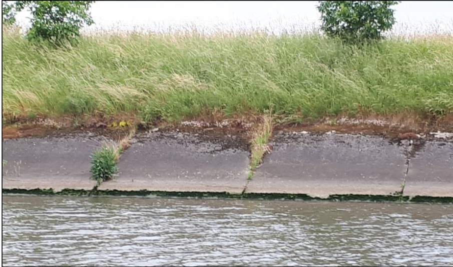
Foto 6. Verstevigde oever met betonnen platen.
