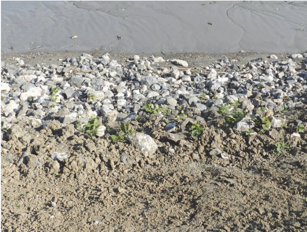
Figuur 71 Uitschietende Japanse duizendknoop ( Fallopia japonica ) op pas aangelegde dijk doordat grond is gebruikt die besmet was met wortelstokken en/of stengels (02/10/2013).
