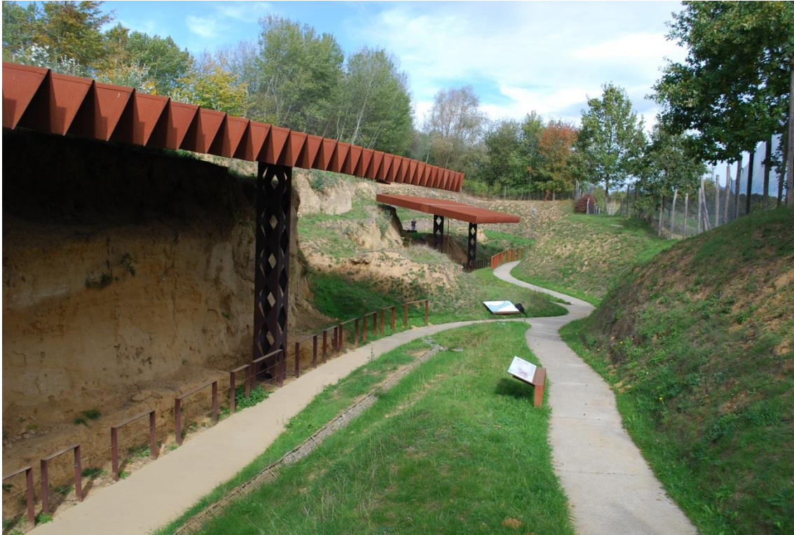
Figuur 1. Overzicht van de site, met links de afgegraven profielwand, met metalen dak-overkapping.
