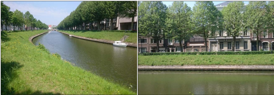
Foto 1 : Huidige oeverversteving door een betonnen kesp langs het kanaal de Coupure te Gent
