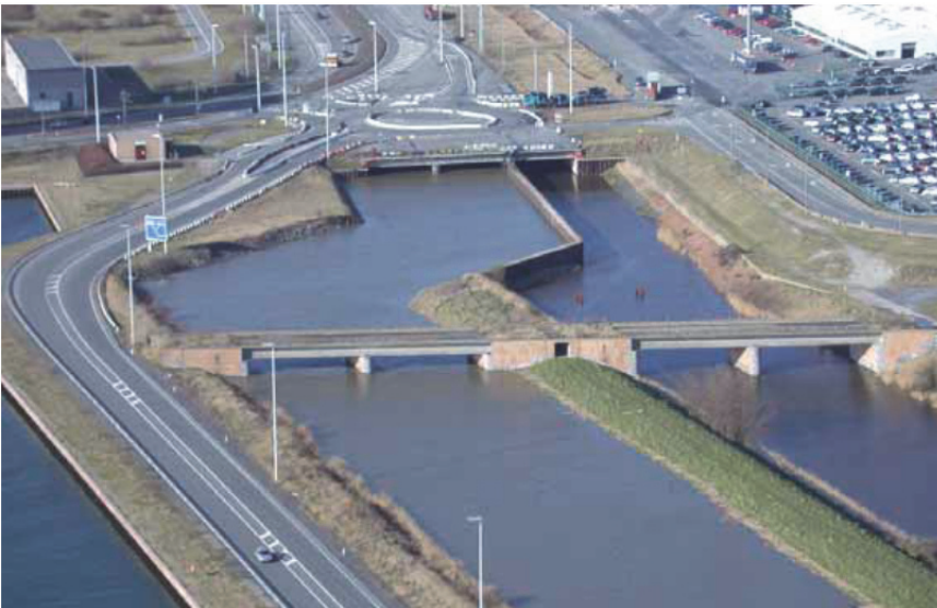
Figuur 4. Zicht op de spuikokers in de voorhaven van Zeebrugge waar het AKL (links) en het LK (rechts) samenkomen.
