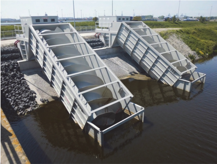
Figuur 3. Vijzelpompen in het LK die bij hoge piekdebieten het overtollige water kunnen verpompen naar het AKL
